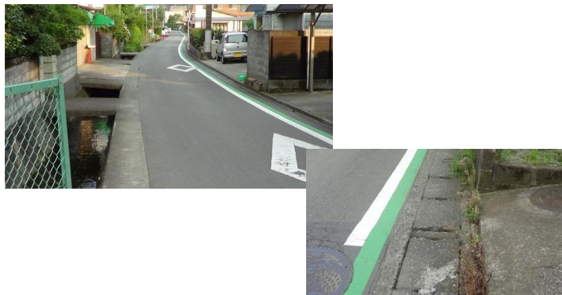
② 府川地区 側溝
