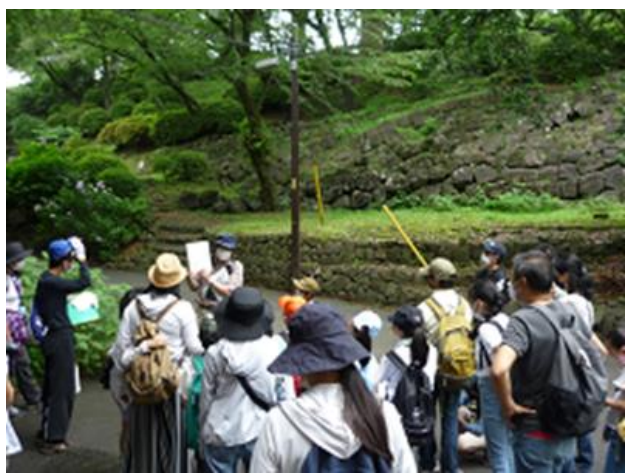
⑨崩れた小田原城の石垣
