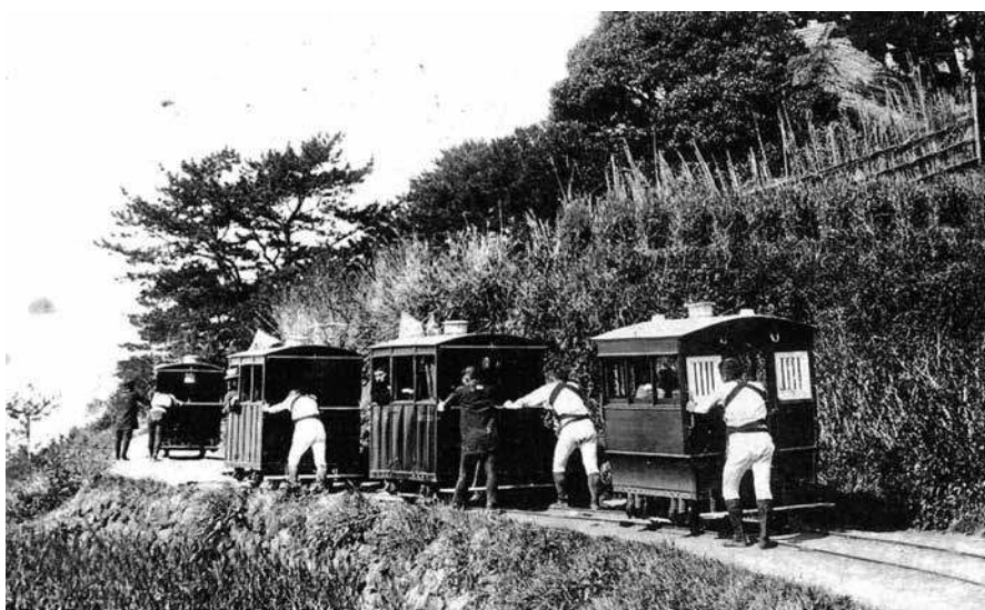
人車鉄道 芥川竜之介の小説「トロッコ」に鉄道建設の風景が描かれている。
