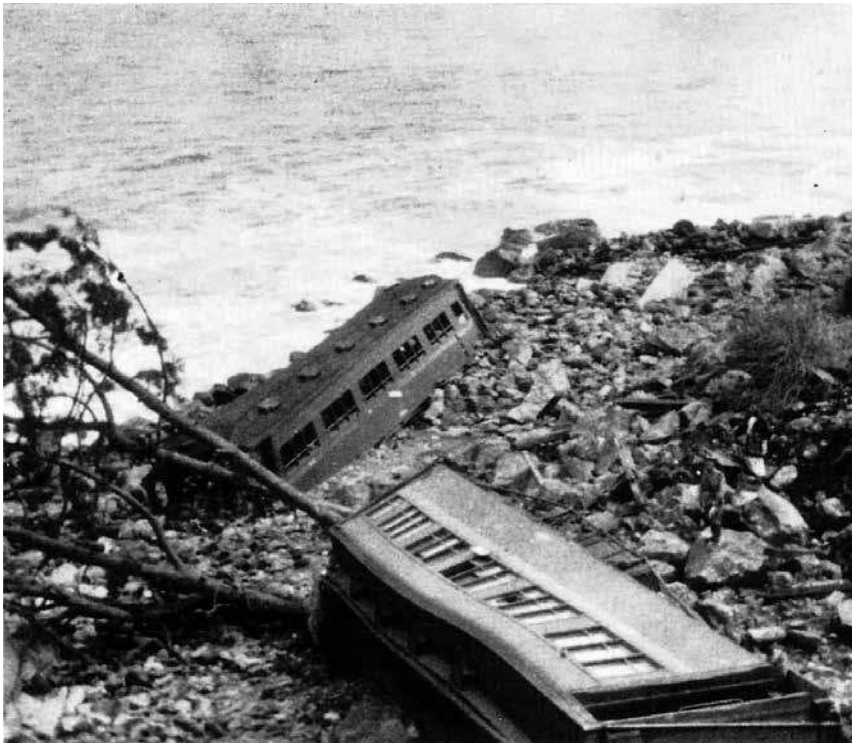
根府川駅から転落した電車
