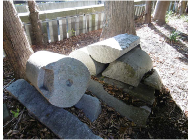
倒壊した御影石の鳥居
