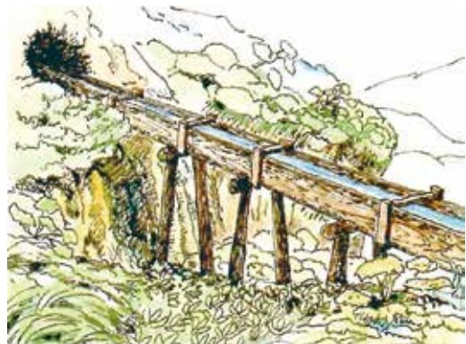
橋のようにして谷や沢をわたした用水路 (箱せぎともいいます)
