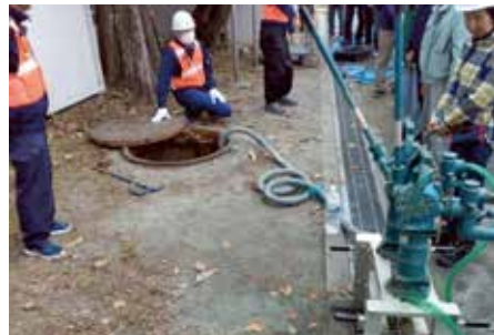
耐震性貯水槽
