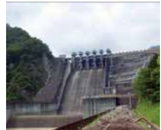
三保ダムの放水口
