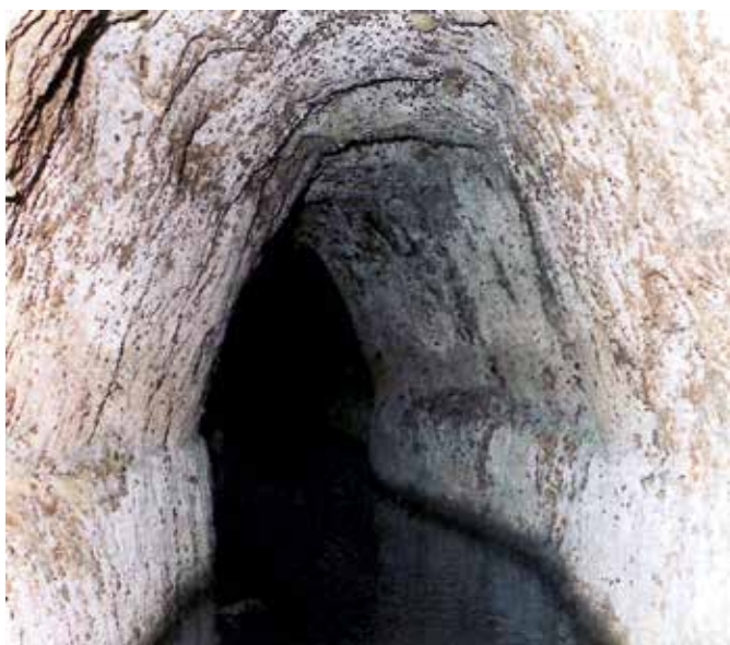
トンネルの中の様子 さくら だ (桜田 さくら 隧道 だ ずい どう ) (高さは、180cmほどあります。)
