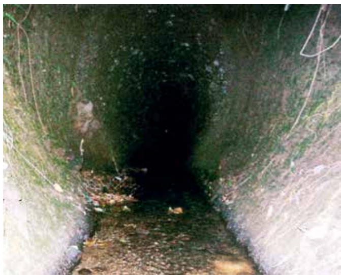
城南中学校近くの狩俣 かり また 隧道 ずい どう 入口
